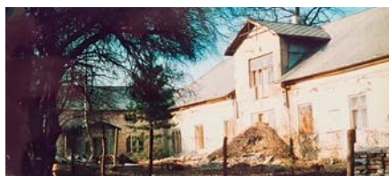
Część południowa dworu przed rozbórką ścian i dachu, fot. z archiwum Zbigniewa Strasia
