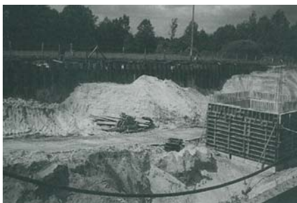
Budowa oczyszczalni, fot. Bolesławskie Prezentacje, Nr 21/2002 i Nr 23/2002
