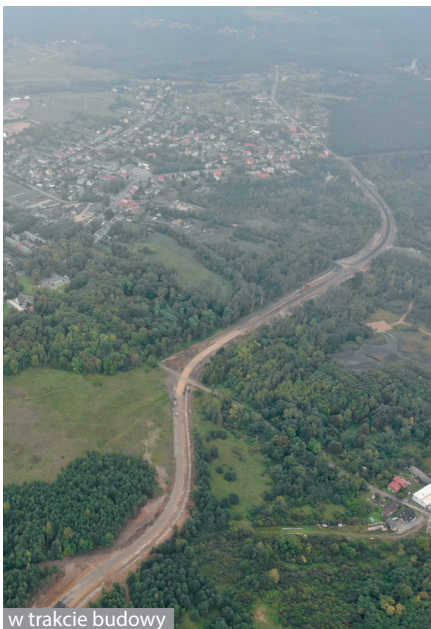
w trakcie budowy
