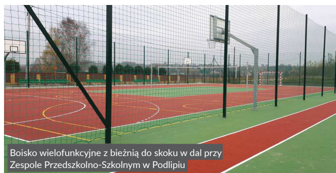
Boisko wielofunkcyjne wraz z bieżnią lekkoatletyczną i bieżnią do skoku w dal przy Zespole Przedszkolno-Szkolnym w Krzykawie
