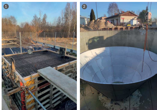
1. Rozbudowa oczyszczalni – budowa nowej studni pomiarowej, fot. B. Dąbek
