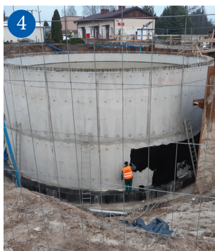
1. Budowa nowego reaktora biologicznego
