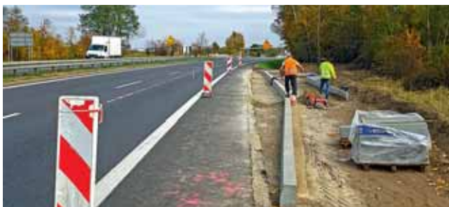
Zatoki w Kolonii przy DK94 w trakcie budowy.
