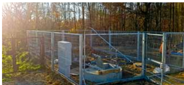
Przepompownia - element kanalizacji ul. Fr. Nullo - podczas prac końcowych.
