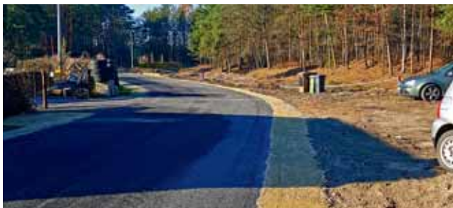
Droga przy lesie - odnoga Kluczewskiej po wykonaniu.
