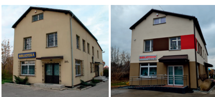
Budynek biblioteki przed i po termomodernizacji
