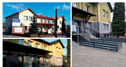
Budynek GOPS przed i po termomodernizacji
