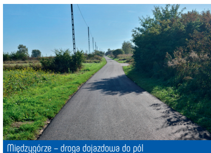
Międzygórze - droga dojazdowa do pól
