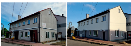
Budynek Domu Wiejskiego przed i po termomodernizacji
