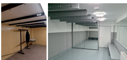
Szatnia przed i po remoncie
