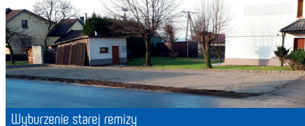
Wyburzenie starej remizy
