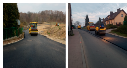
Odtworzenie dróg po rozbudowie kanalizacji na drogach w Krzykawce [ul. Miodowa, ul. Starowiejska]
