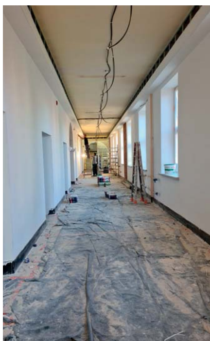
Remont korytarzy szkolnych
