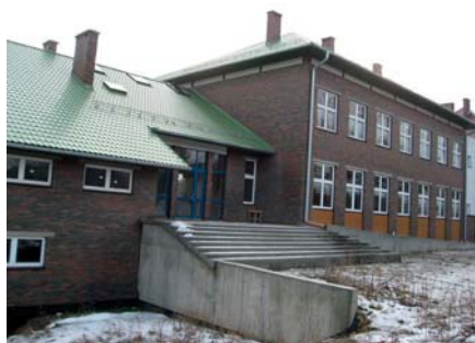
Rozbudowa SP w Bolesławiu na potrzeby gimnazjum, fot. arch. gimnazjum, 2007-2008
