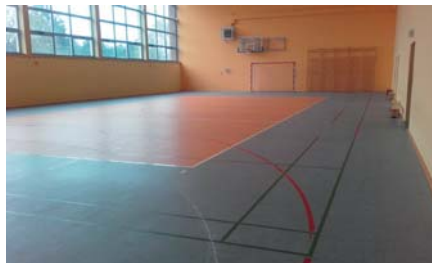
Budowa sali gimnastycznej, fot. arch. gimnazjum, 2014
