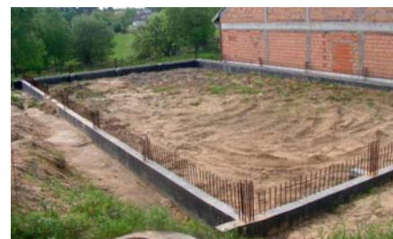
Fundamenty sali gimnastycznej, fot. arch. gimnazjum, 2012
