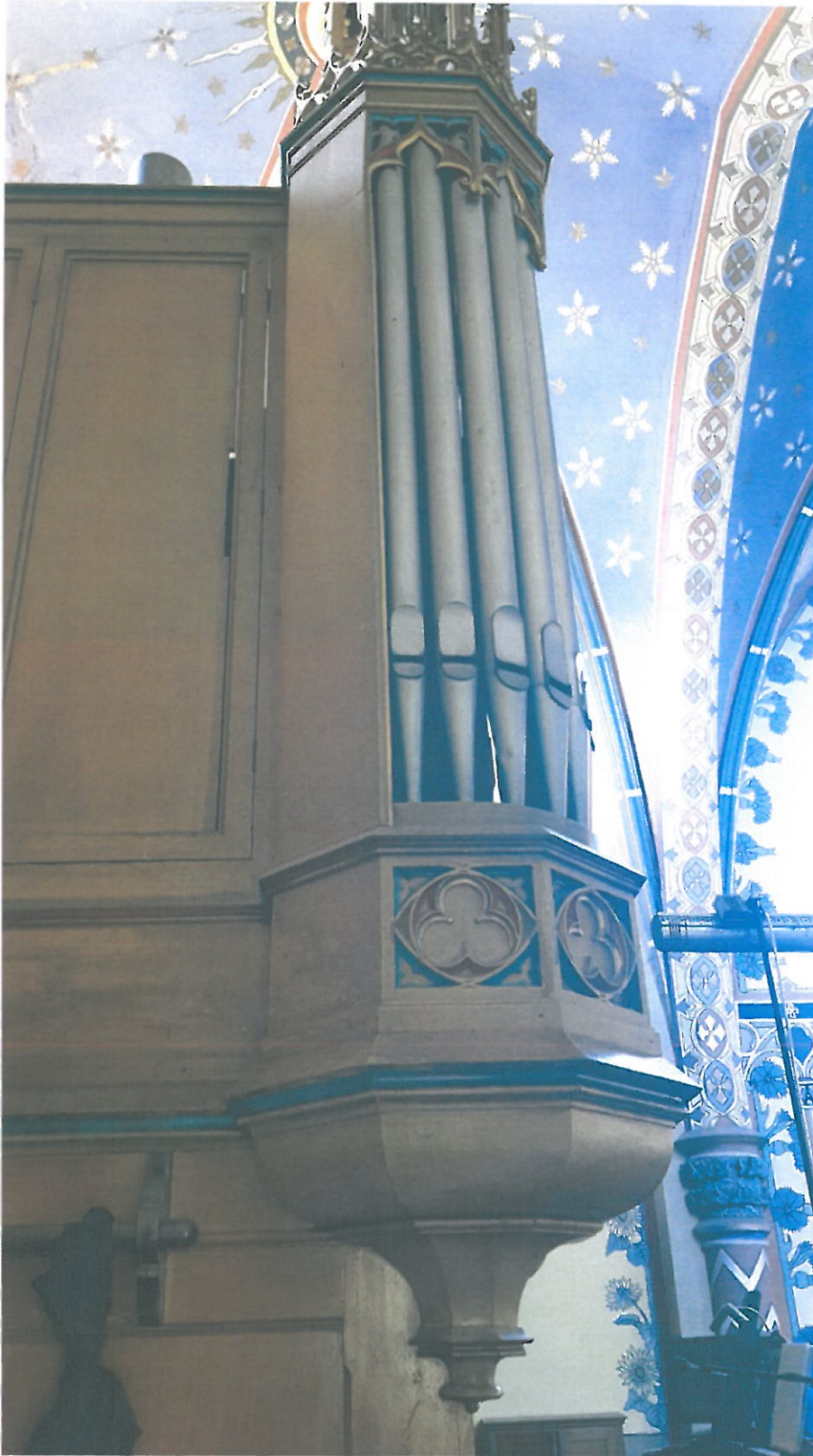
Fot. 5. Bolestaw, Kościół parafialny p.w. Macierzyństwa NMP i Św. Michała Archanioła. Wieloboczna wieża mieszcząca piszczałki w narożniku południowym oraz fragment płycinowego boku szafy. Widoczne zbrudzenia na powierzchni struktury oraz przetarcia lakieru .
