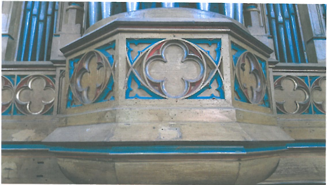
Fot. 8, 9. Bolesław, Kościół parafialny p.w. Macierzyństwa N M P i Św. Michała Archanioła. Fragmenty prospektu organowego przedstawiające odcinki, fryzu maswerkowego u podstawy piszczałek. Widoczne zabrudzenia powierzchni, wtórne powłoki poźółkłego lakieru oraz liczne otwory wylotowe owadziich szkodników drewna.
