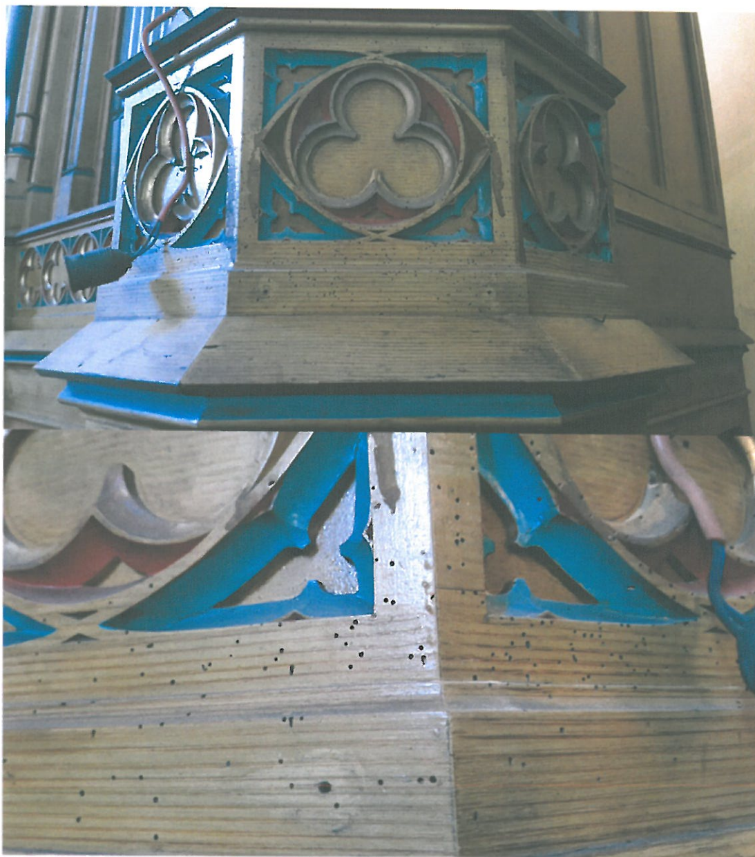
Fot. 10, 11. Bolesław, Kościół parafialny p.w. Macierzyństwa NMP i Św. Michała Archanioła. Fragmenty prospektu organowego przedstawiające odcinki, fryzu maswerkowego u podstawy piszczalek. Widoczne zabrudzenia powierzchni, liczne otwory wylotowe owadów szkodników drewna oraz przetarte zniszczone warstwy złoceń na wklęsłach czworoliści.
