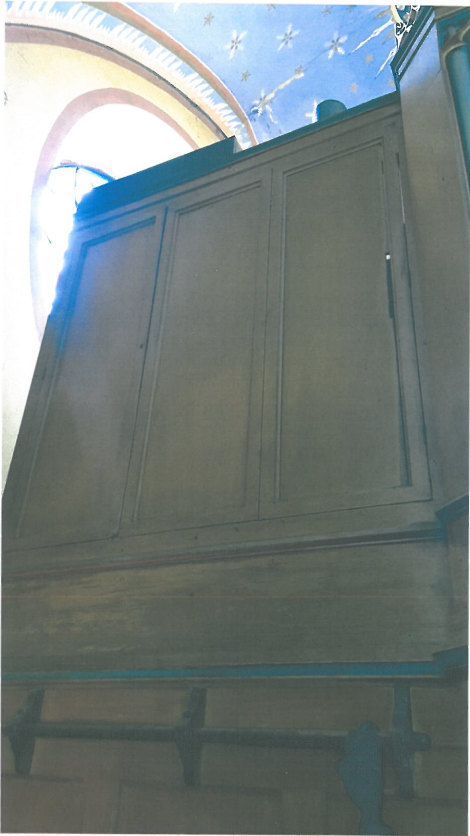
Fot. 18. Bolesław, Kościół parafialny p.w. Macierzyństwa N M P i Św. Michała Archanioła. Bok płycinowy szafy organowej z fragmentem przemalowanej wtórnie płycinowej podbudowy. Widoczne mocne zabrudzenia powierzchni, wtórne powłoki pociemniałego, lakieru na bazie szelaku miejscami poprzecierane.
