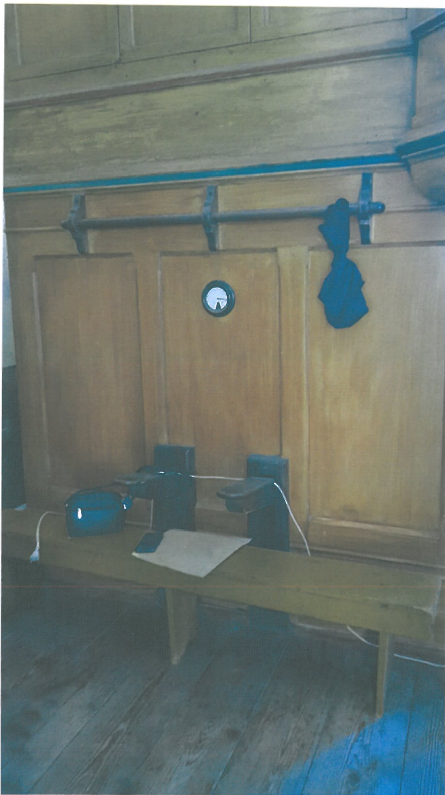
Fot. 19. Bolesław, Kościół parafialny p.w. Macierzyństwa N M P i Św. Michała Archanioła. Bok przemalowanej wtórnie płycinowej podbudowy z fragmentem górnym płycinowej szafy organowej. Widoczne mocne zabrudzenia powierzchni, wtórne powłoki pociemniałego, lakieru na bazie szelaku miejscami poprzecierane.
