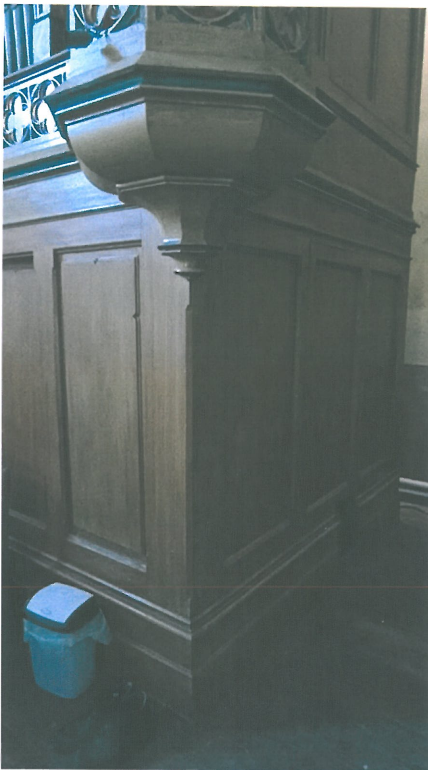
Fot. 16. Bolesław, Kościół parafialny p.w. Macierzyństwa N M P i Św. Michała Archanioła. Fragment narożnika północnego z podbudową pływicową szafy organowej. Widoczne zabrudzenia powierzchni, wtórne powłoki połóżtkiego lakieru oraz wtórny mazerunek w dolnej partii szafy na pływicowej podbudowie.
