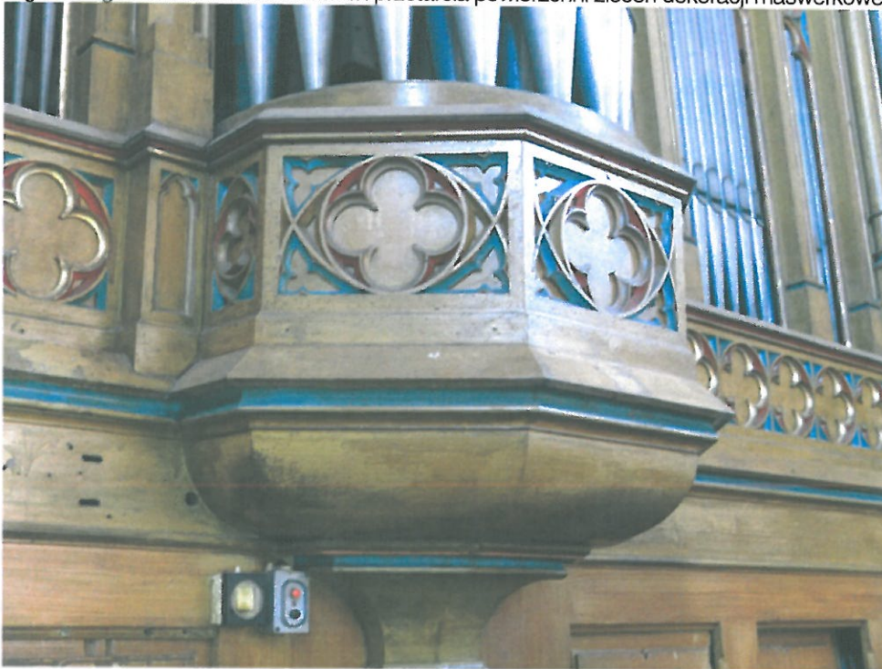
Fot. 14. Bolestaw, Kościół parafialny p.w. Macierzyństwa N M P i Św. Michała Archanioła. Fragment prospektu organowego ze wspornikiem wieży centralnej. Widoczne zabrudzenia powierzchni, wtórne powłoki pożółkłego lakieru, liczne otwory wylotowe owadzi szkodników drewna oraz wtórny mazerunek w dolnej partii szafy na płytynowej podbudowie.
