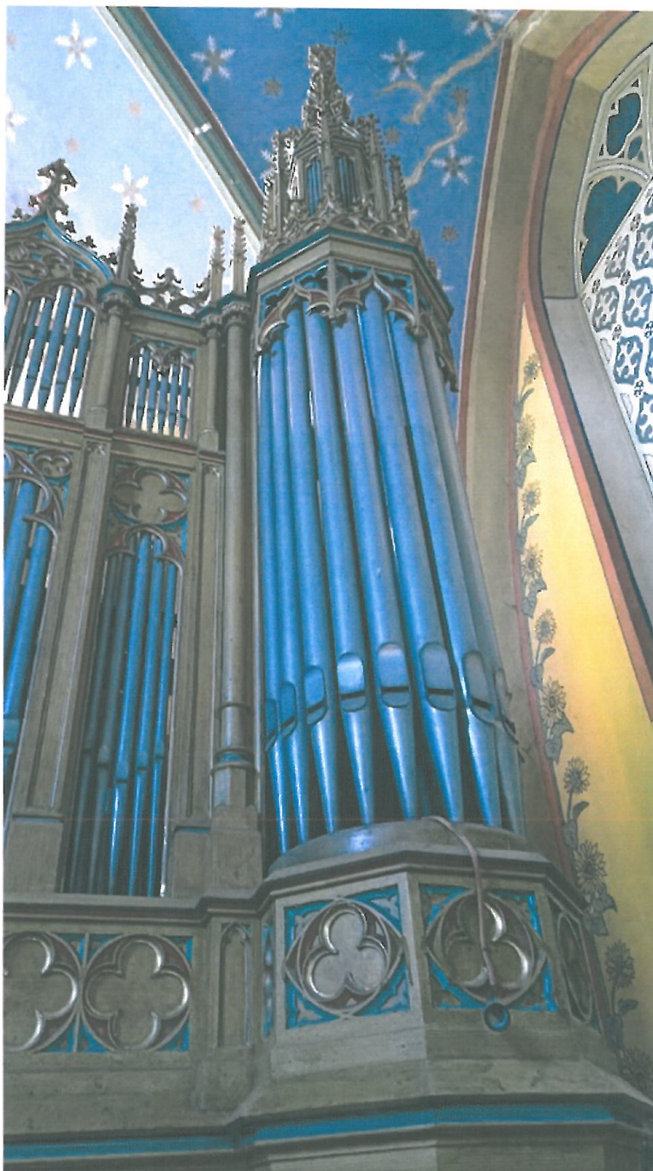
Fot. 15. Bolesław, Kościół parafialny p.w. Macierzyństwa N M P i Św. Michała Archanioła. Fragment narożnika północnego z wieżą. Widoczne zabrudzenia powierzchni, wtórne powłoki pociemniałego lakieru .
